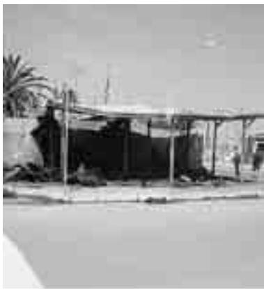
IL CAPANNO DISTRUTTO DAL FUOCO
