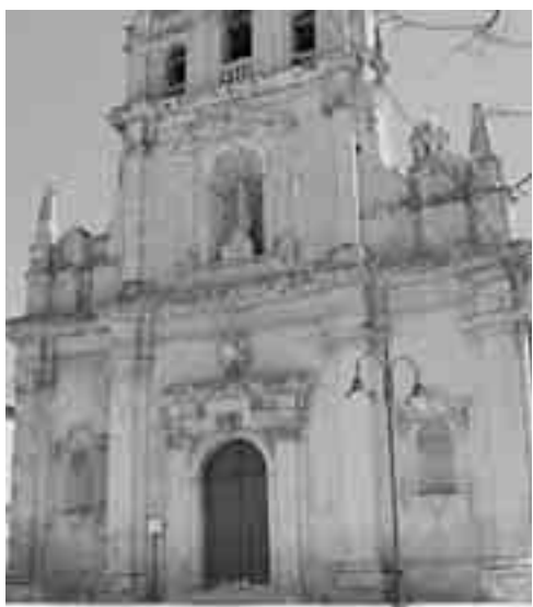
LA CHIESA DI SANTA VENERA
