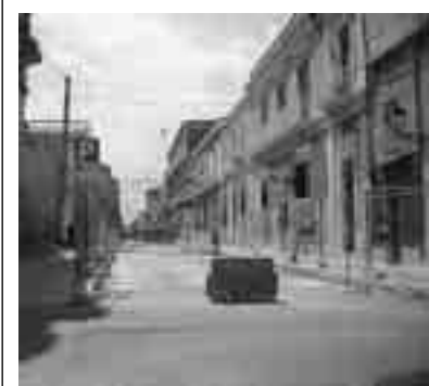
I lavori sul tratto di corso Vittorio Emanuele nel tratto di fronte alla chiesa di San Giovanni
